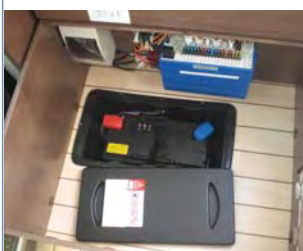
Compartiment électrique cellule
