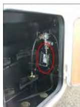
Frappe à froid via fenêtre dans coffre à gaz
